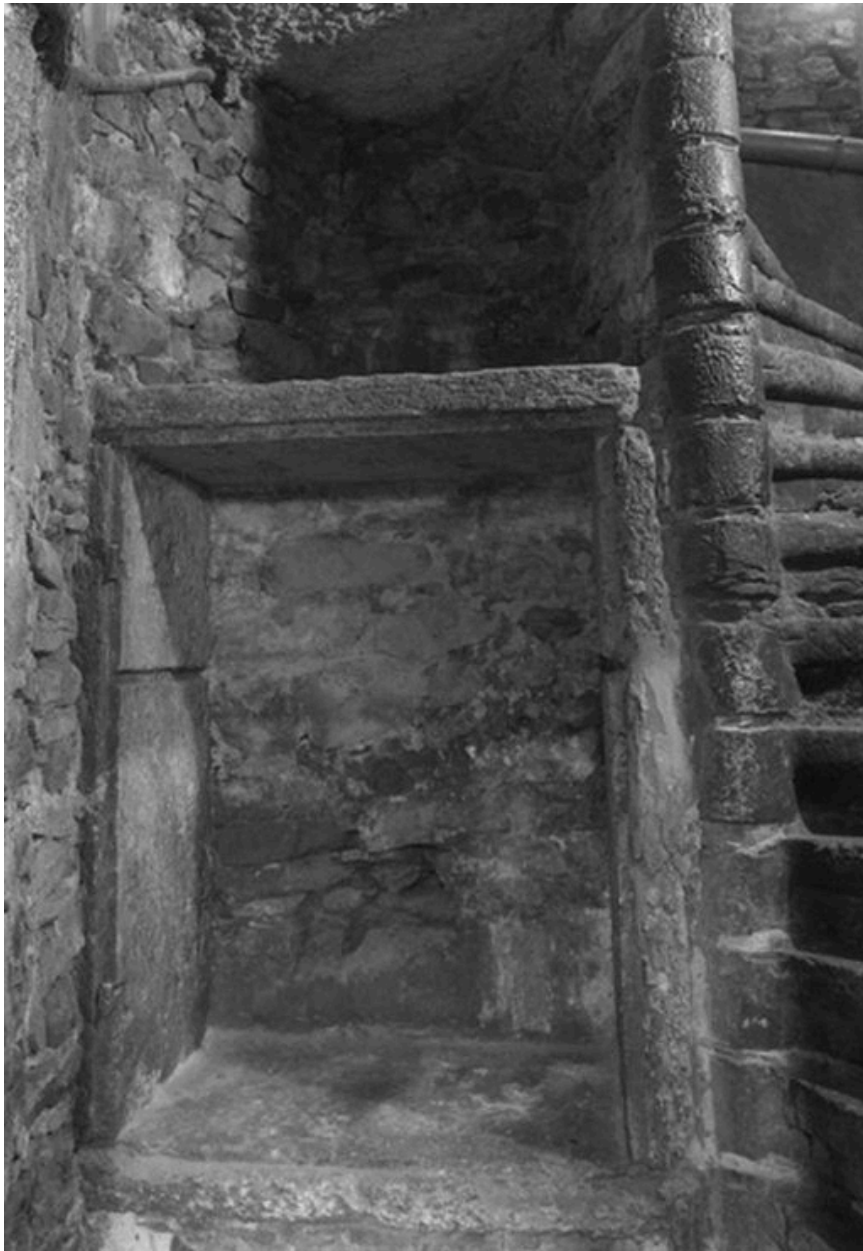
Cave : niche située au pied de l'escalier
