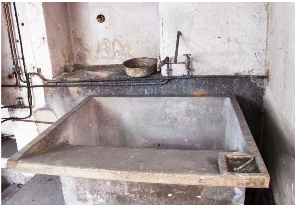
Bassin au sous-sol
