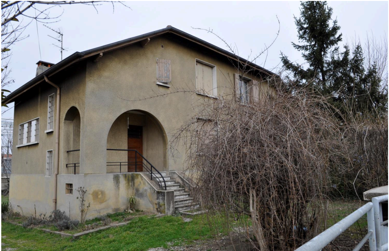
Vue d'extérieur, logements ouvriers, cité EDF
