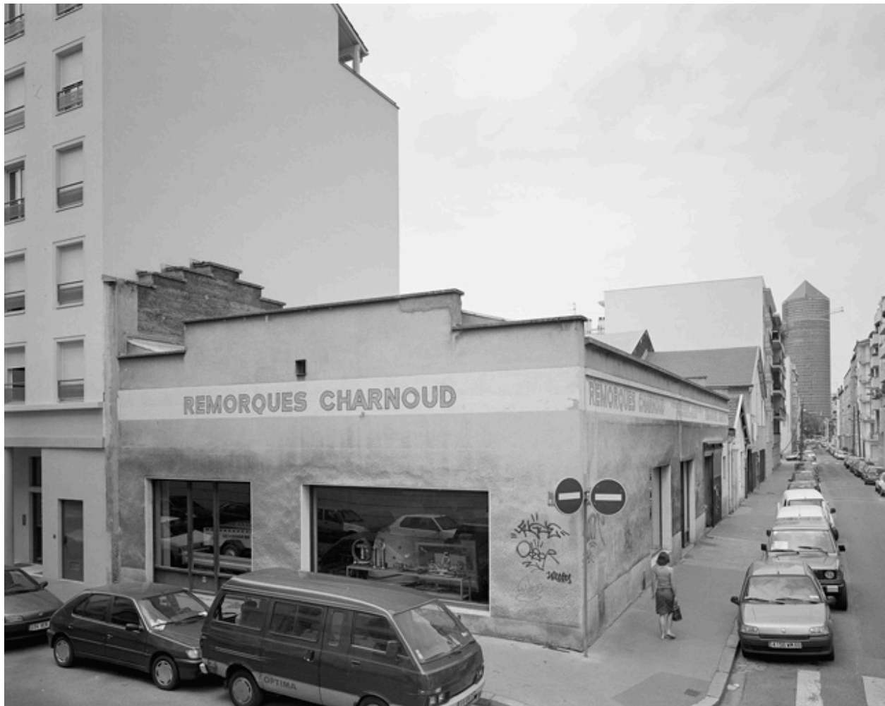
Vue sud-est, extension 1907.
