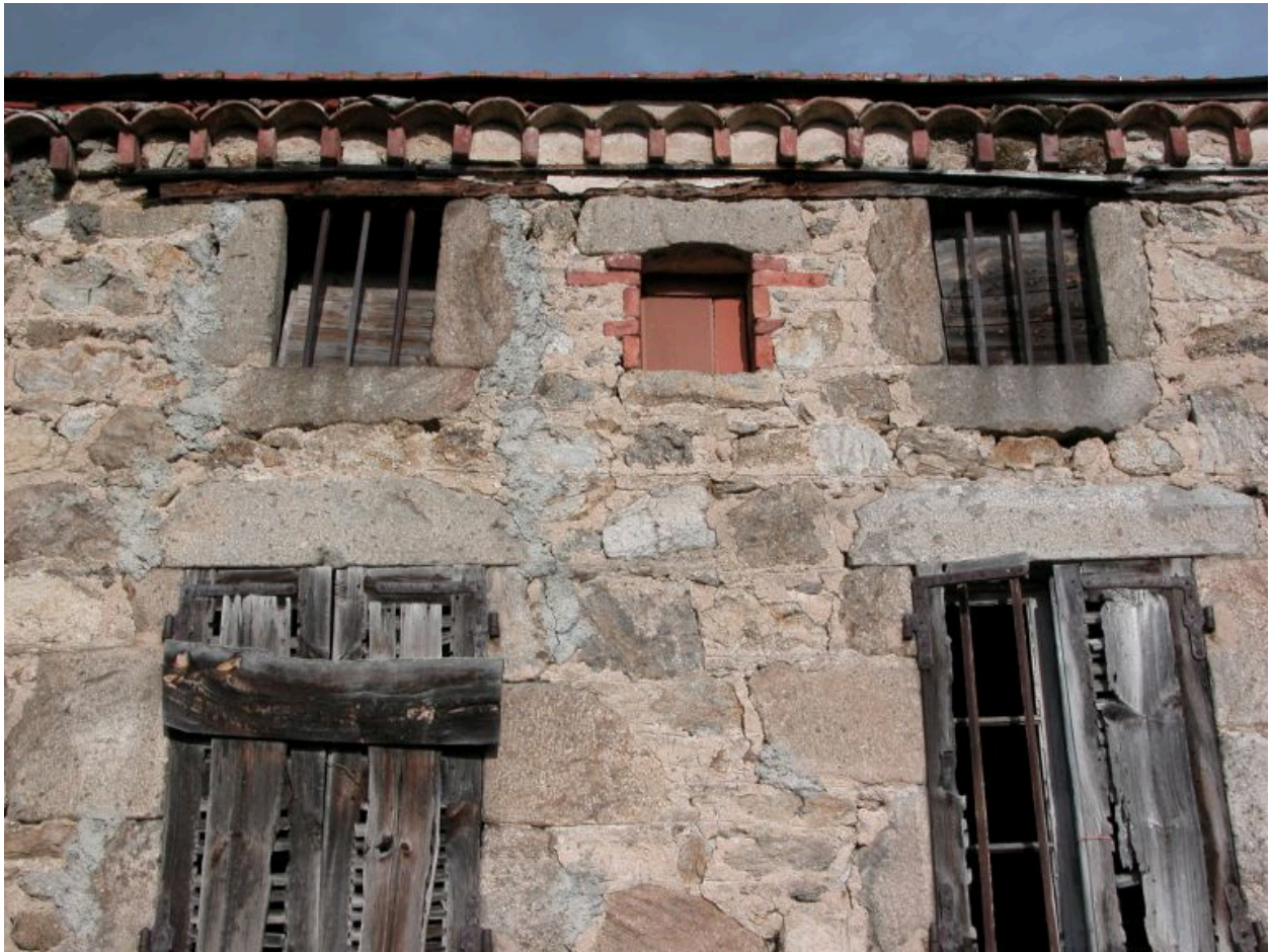
Détail des baies de la façade principale.
