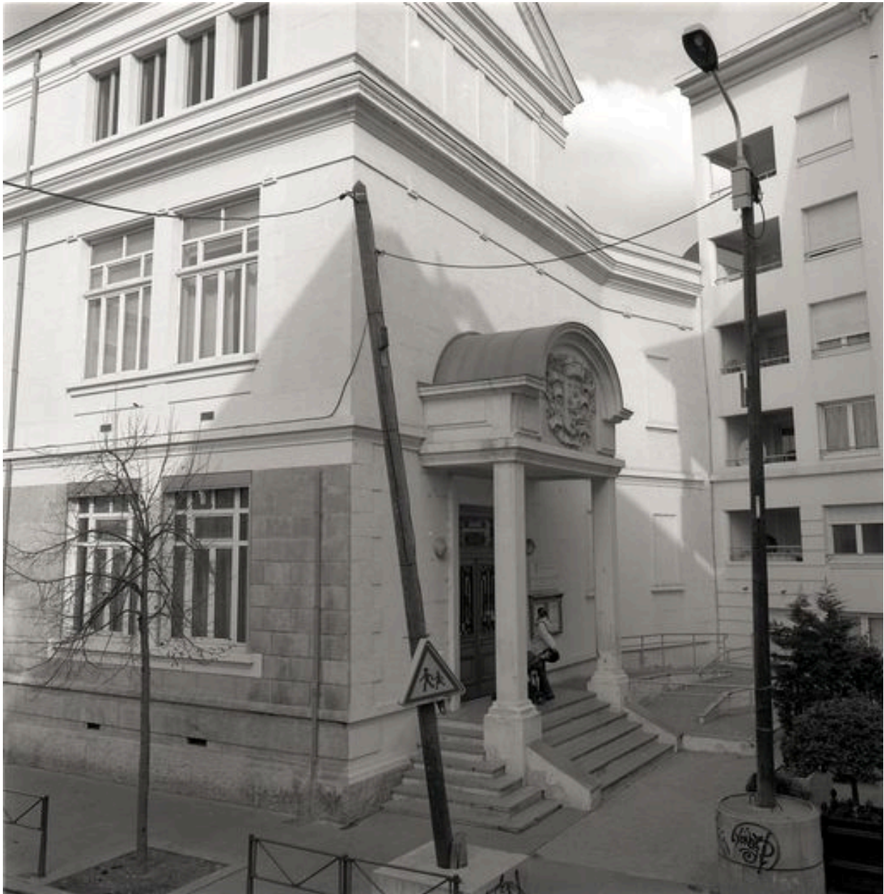
Vue de l'entrée de l'école maternelle depuis le sud-est
