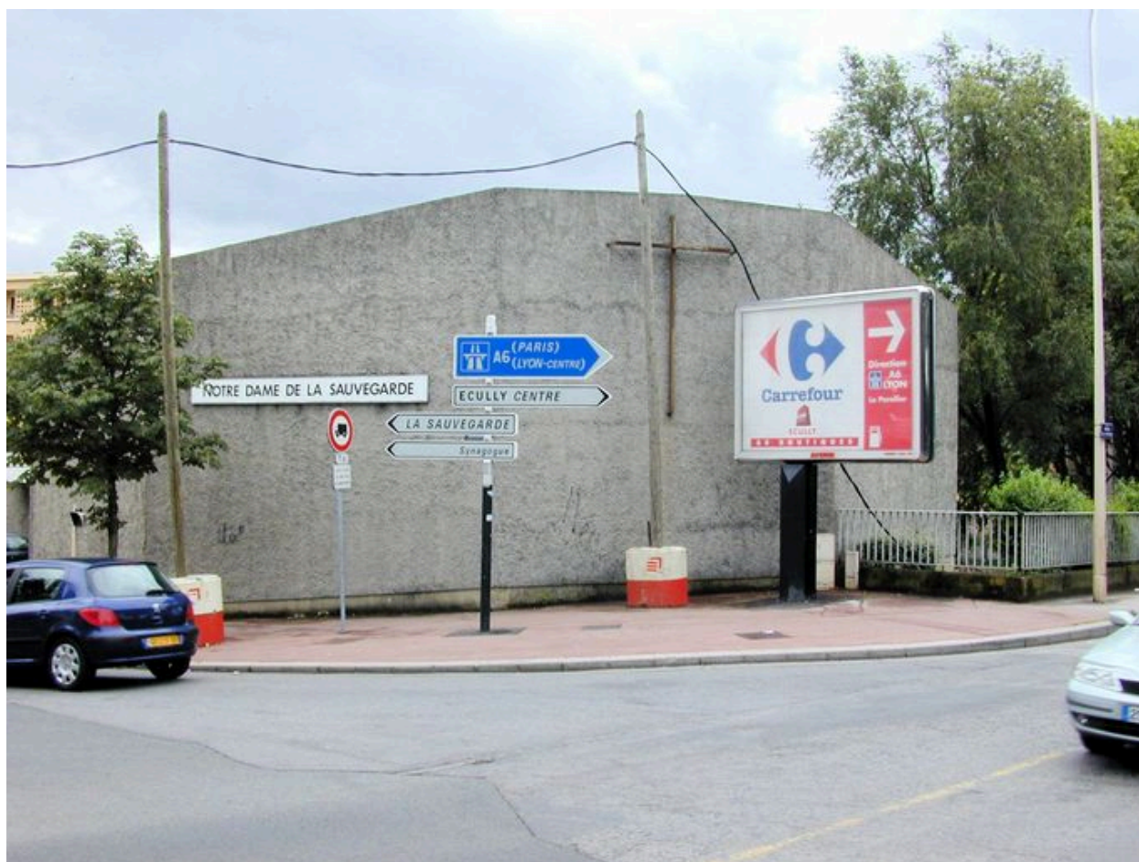
Etat des lieux parès incendie, vue de l'église depuis le nord
