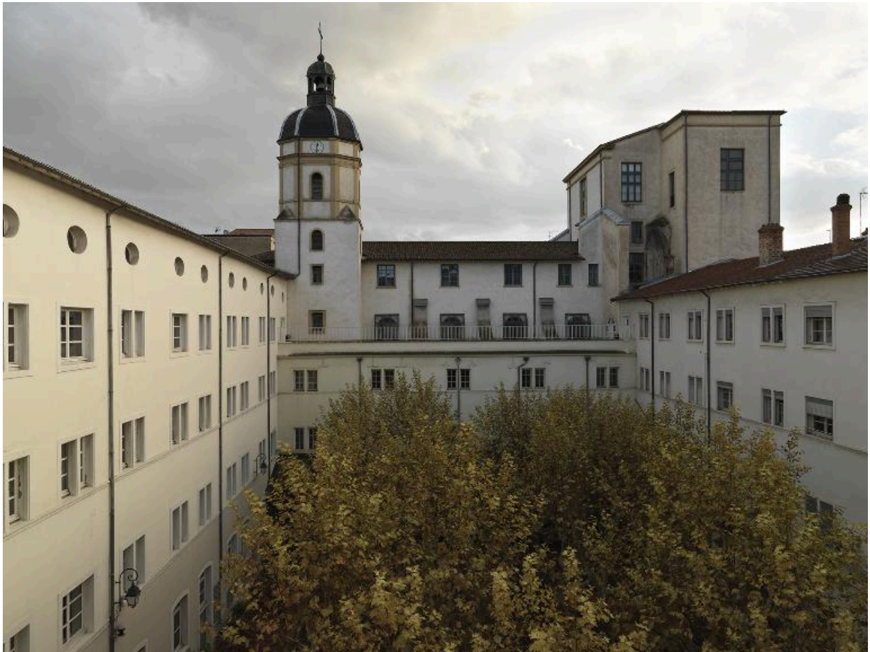
Cour d'honneur, vue d'ensemble depuis le nord
