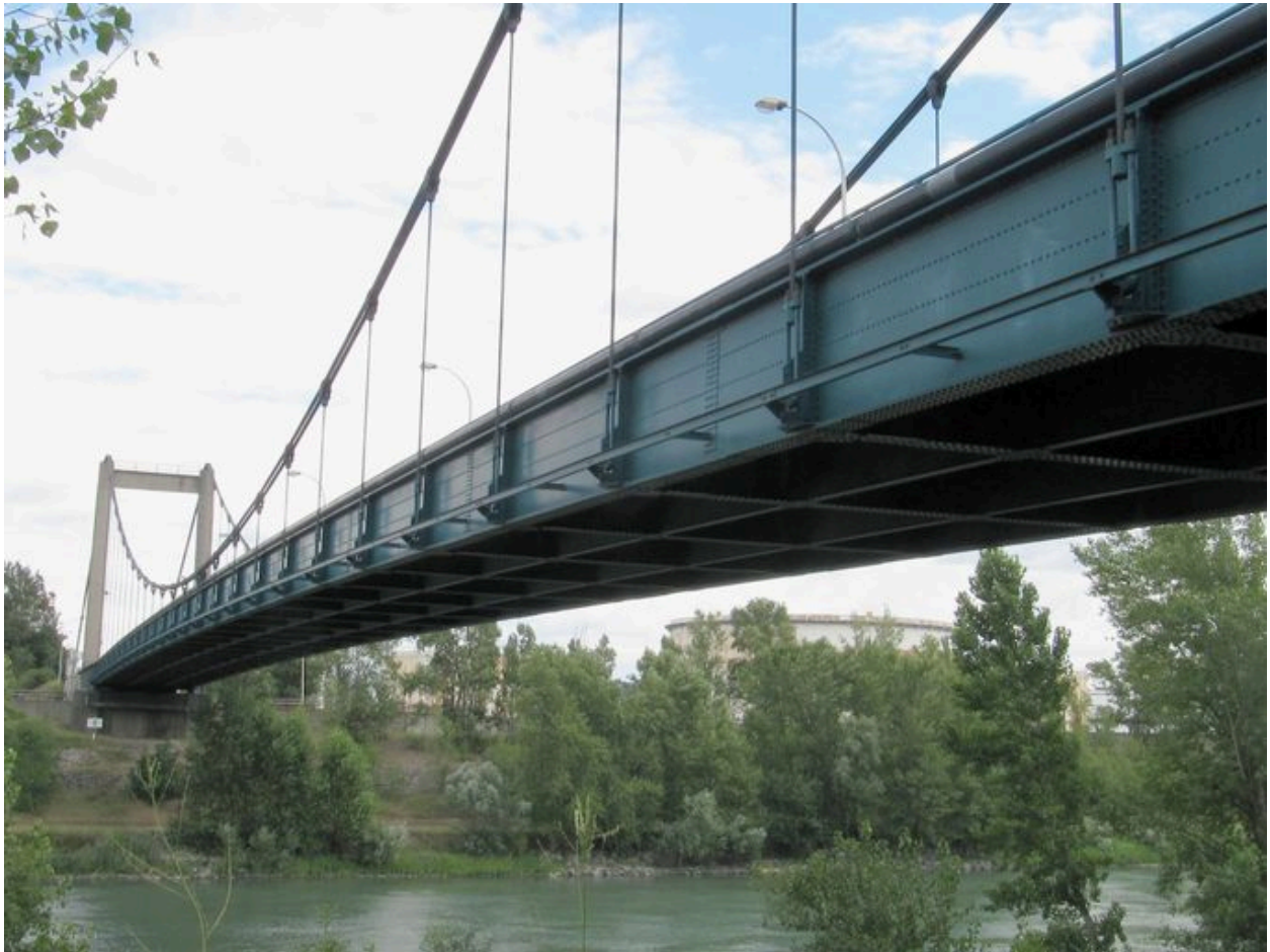
Tablier, face amont (depuis la rive droite)
