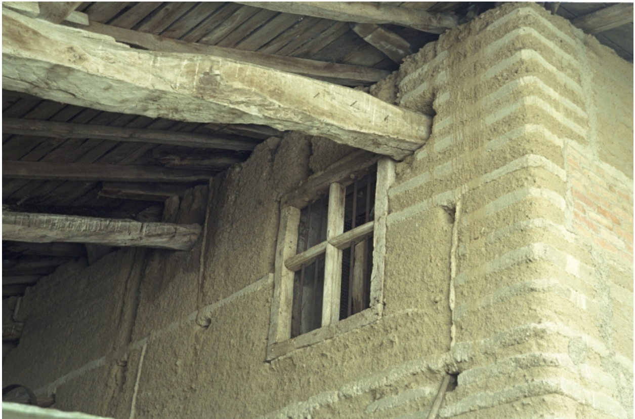
Premier ensemble. Bâtiment sud-est : détail d'une baie de la façade latérale nord-est du logis.
