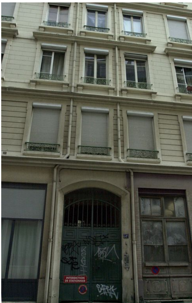
Elévation principale : les travées centrales
