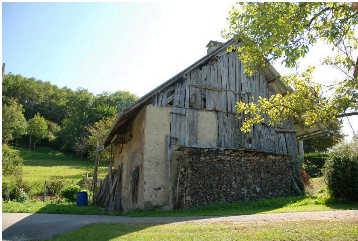
Vue latérale (façade ouest).
