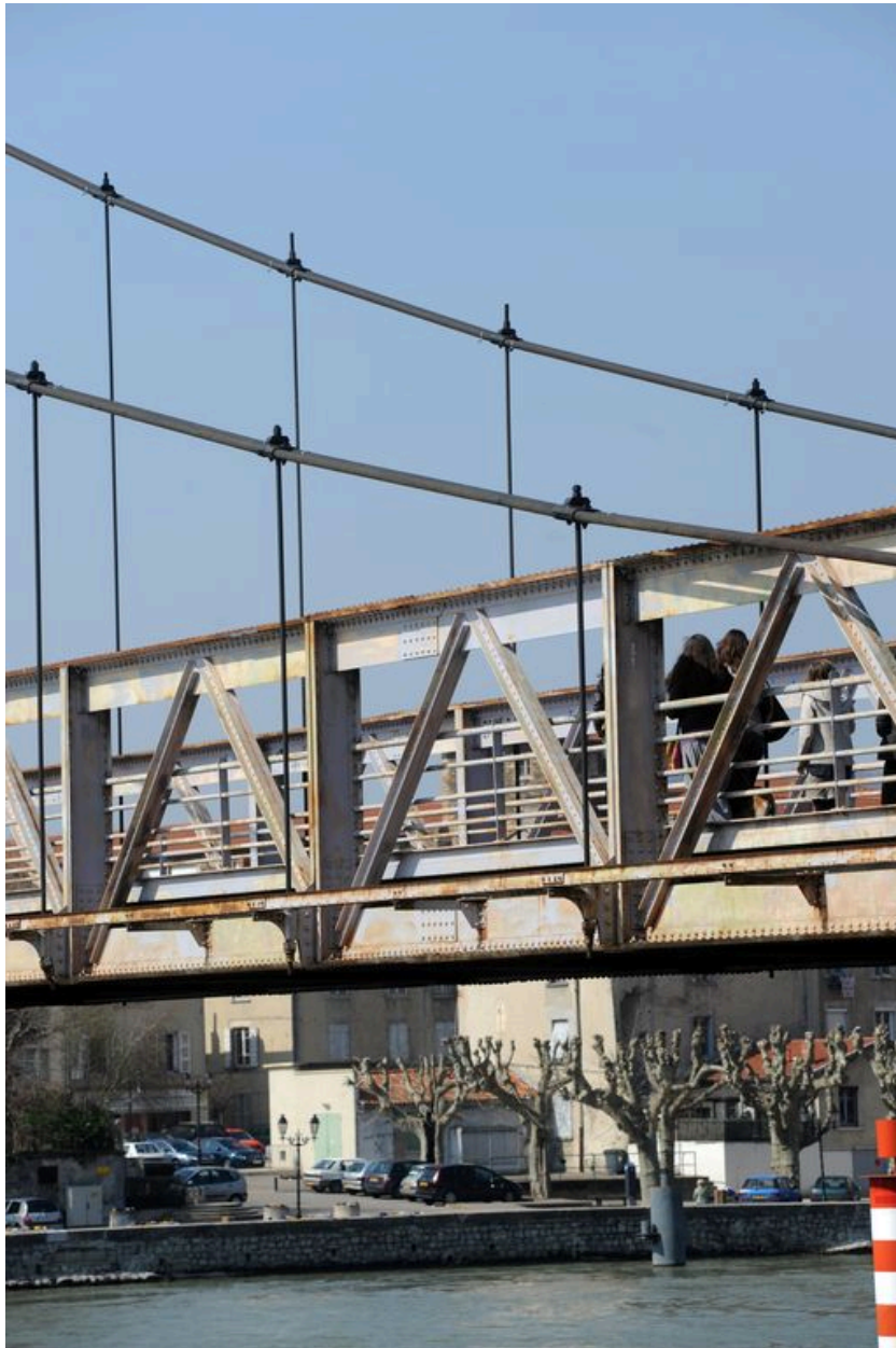
Travée gauche, face aval, vue partielle : suspentes et câbles porteurs (depuis la rive gauche)
