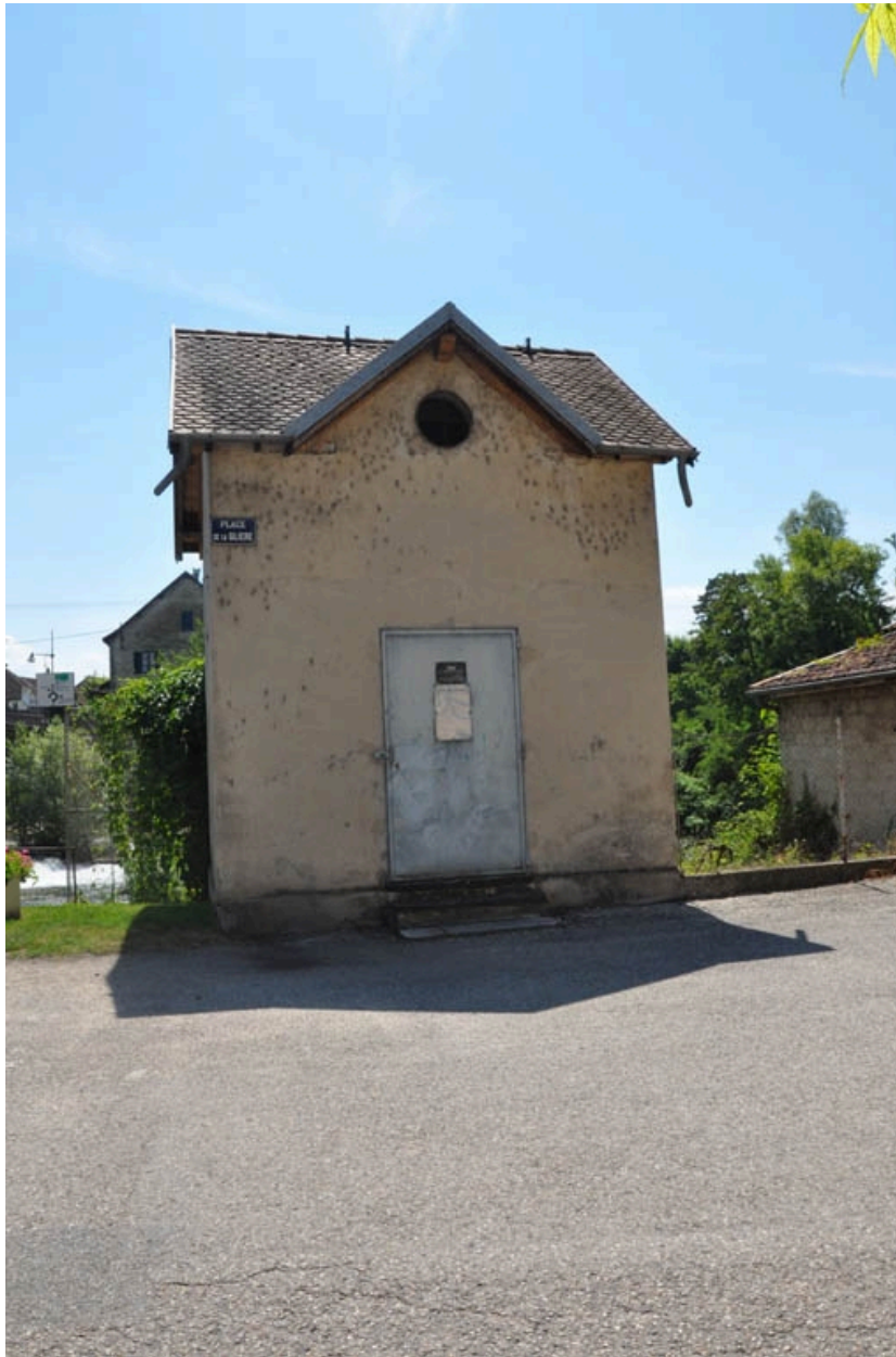
Vue du transformateur
