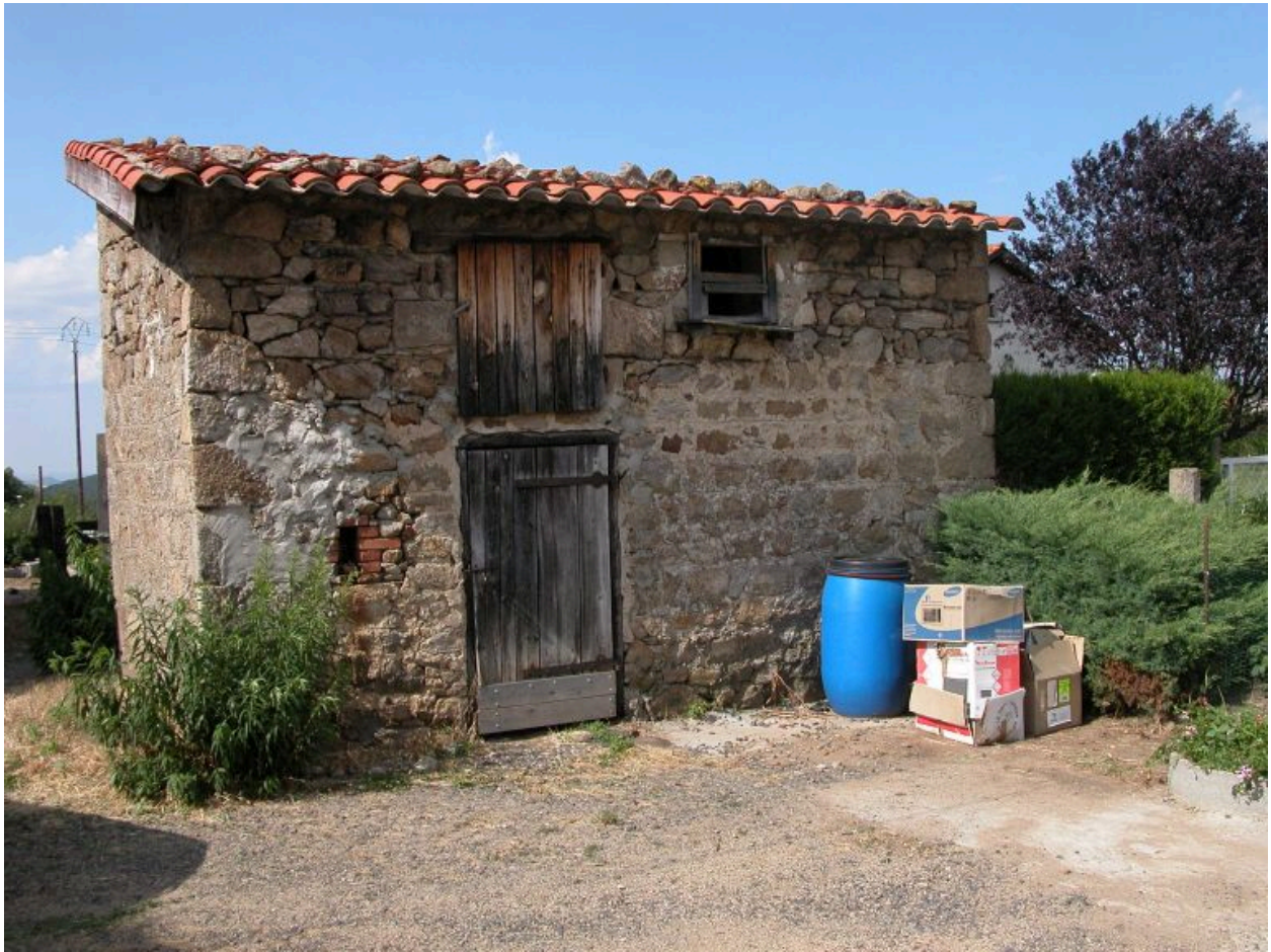
Quérézieux (1986 AM 56). Edifice agricole, vue d'ensemble.
