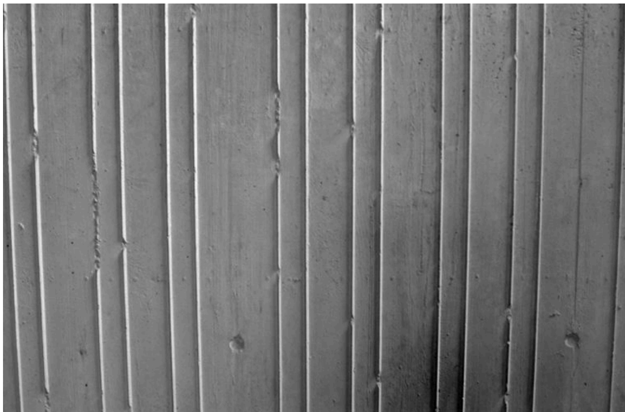
Mur du chevet. Détail du béton
