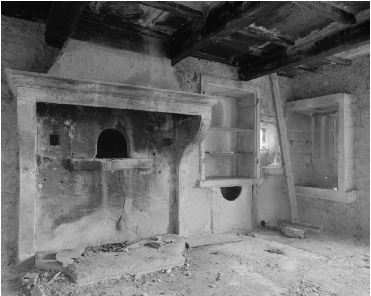
Pièce principale du logis : détail de la cheminée, du four à pain, du potager et de la souillarde.
