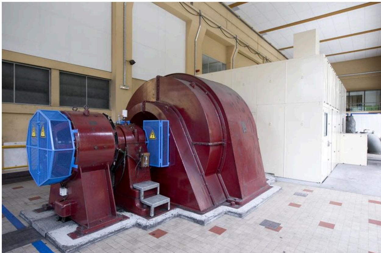
Groupe 2 composé d'une turbine type Francis et d'un alternateur de 12 000 Kw
