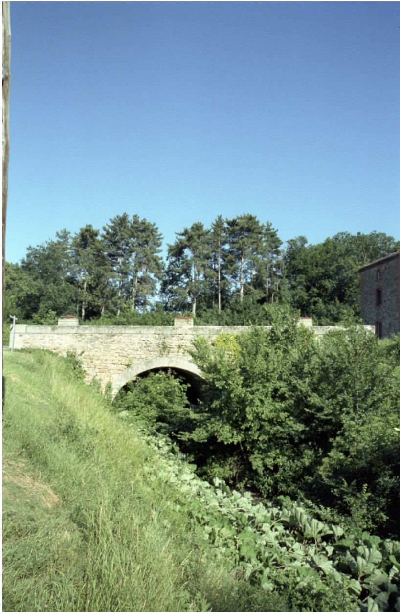
Vue d'ensemble du pont sur le Drugent au Pavé (1987 B4 NC, près de 487).
