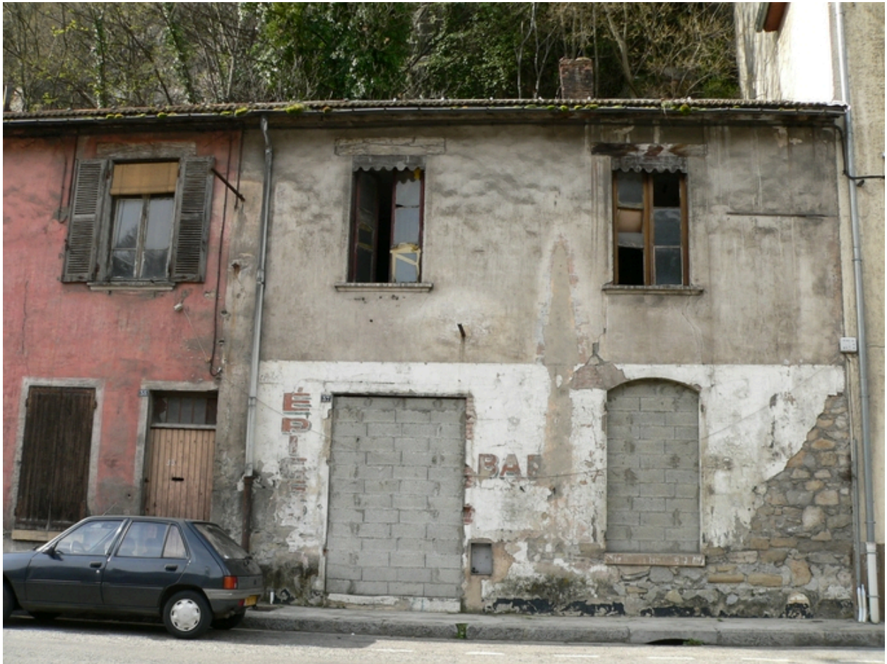
Façade principale sur rue
