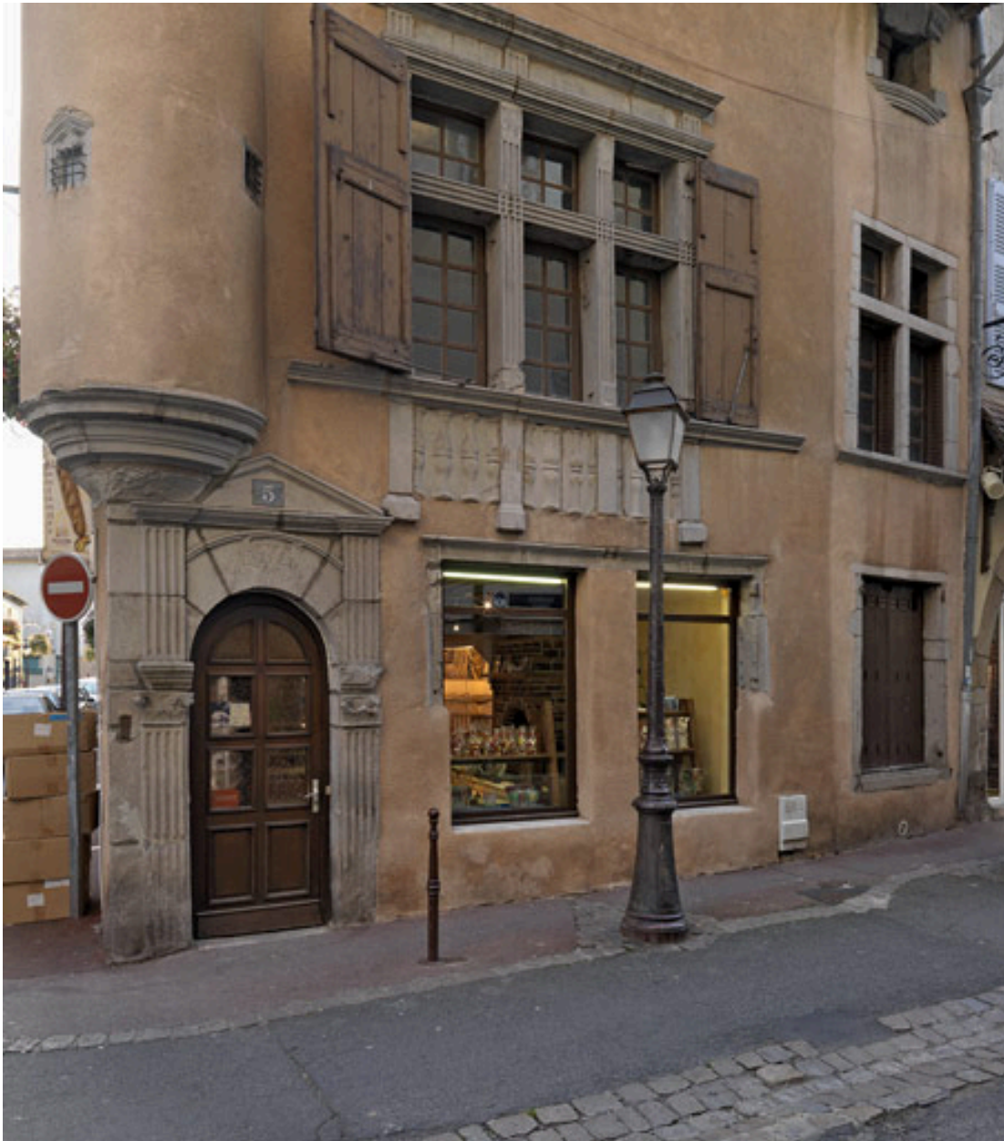
Vue partielle de élévation principale, rue Martin-Bernard.
