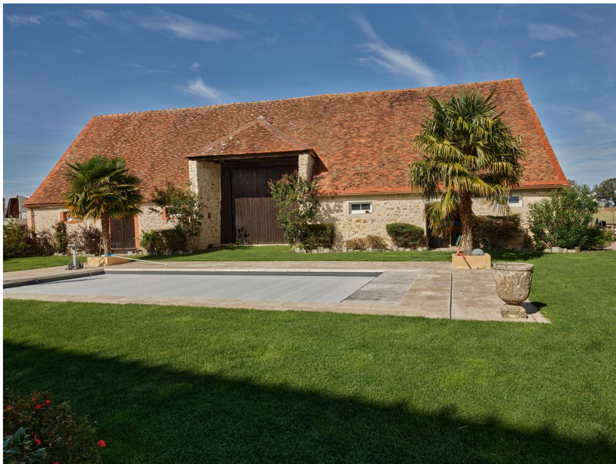
Vue générale de la grange étable.
