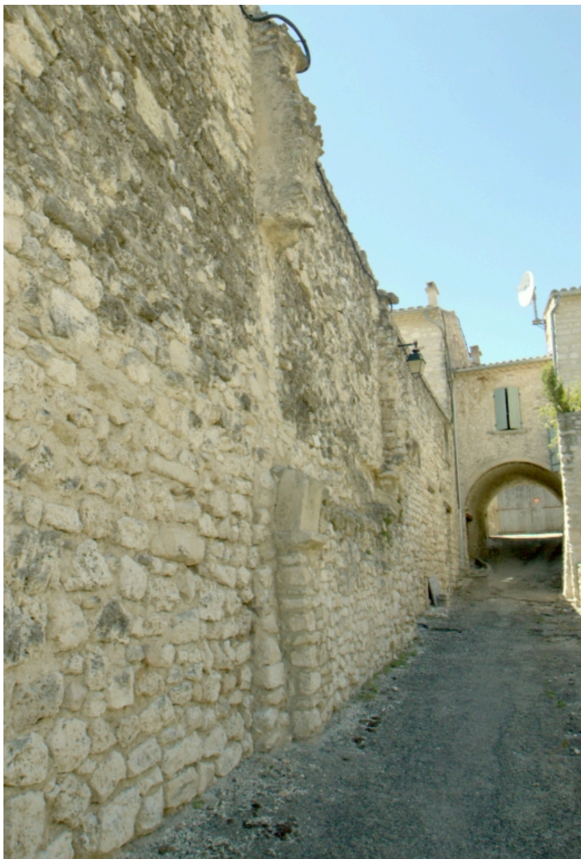
Rue du Calabert, prise depuis l'est : trace de porte et passage couvert ouvrant sur la Grande rue.
