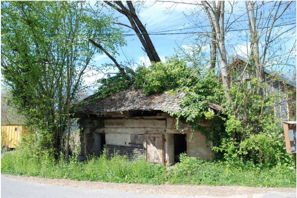
Vue d'ensemble de face de la porcherie
