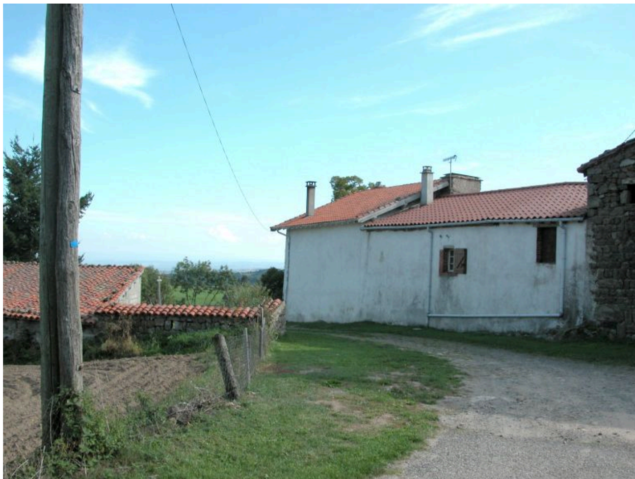
Elévation nord du logis de la ferme parcelle 82.
