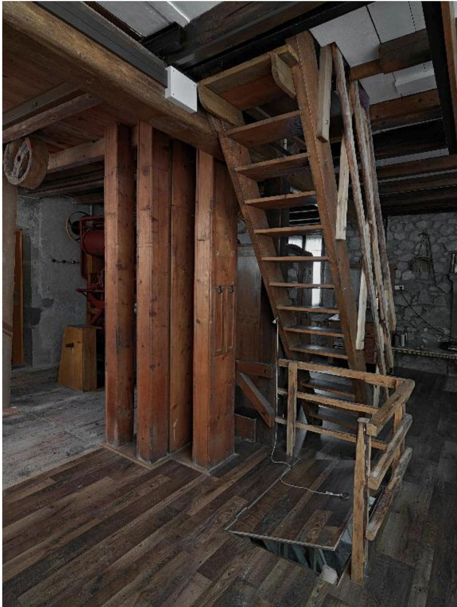
Rez-de-chaussée surélevé : vue des circulations verticales (trappe et échelles de meunier vers le soubassement et vers le comble ; trémies avec ascenseurs à godets).
