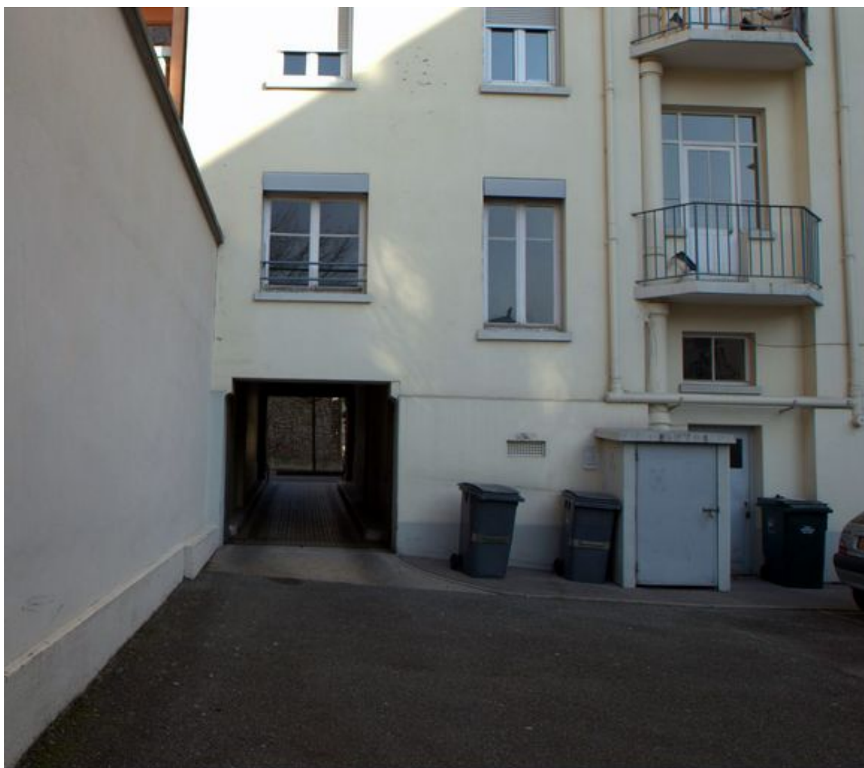
Passage cocher, depuis la cour
