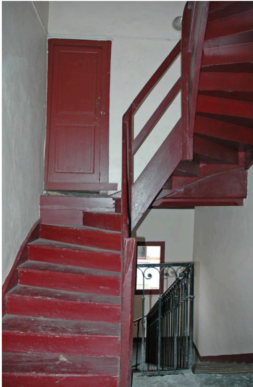
Première volée d'escalier en bois desservant le 3ième étage
