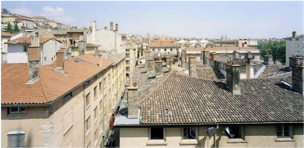
Vue de situation depuis la toiture de la cathédrale Saint-Jean
