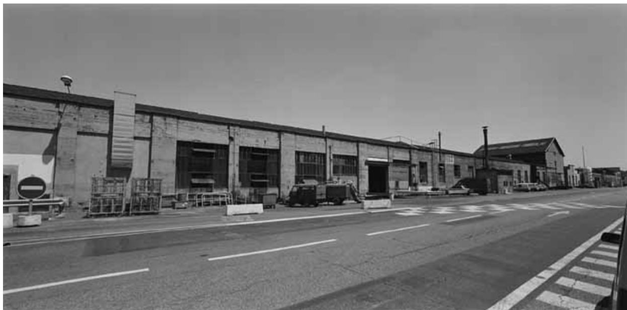
Usine moteur, vue ouest, avenue B
