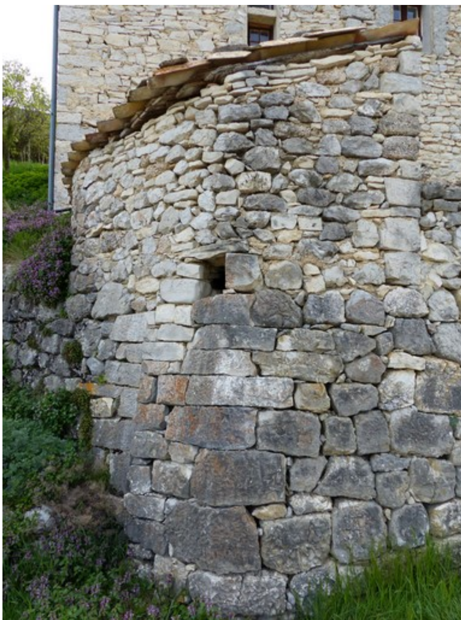
Mur de soutènement de la cour, angle sud-ouest.
