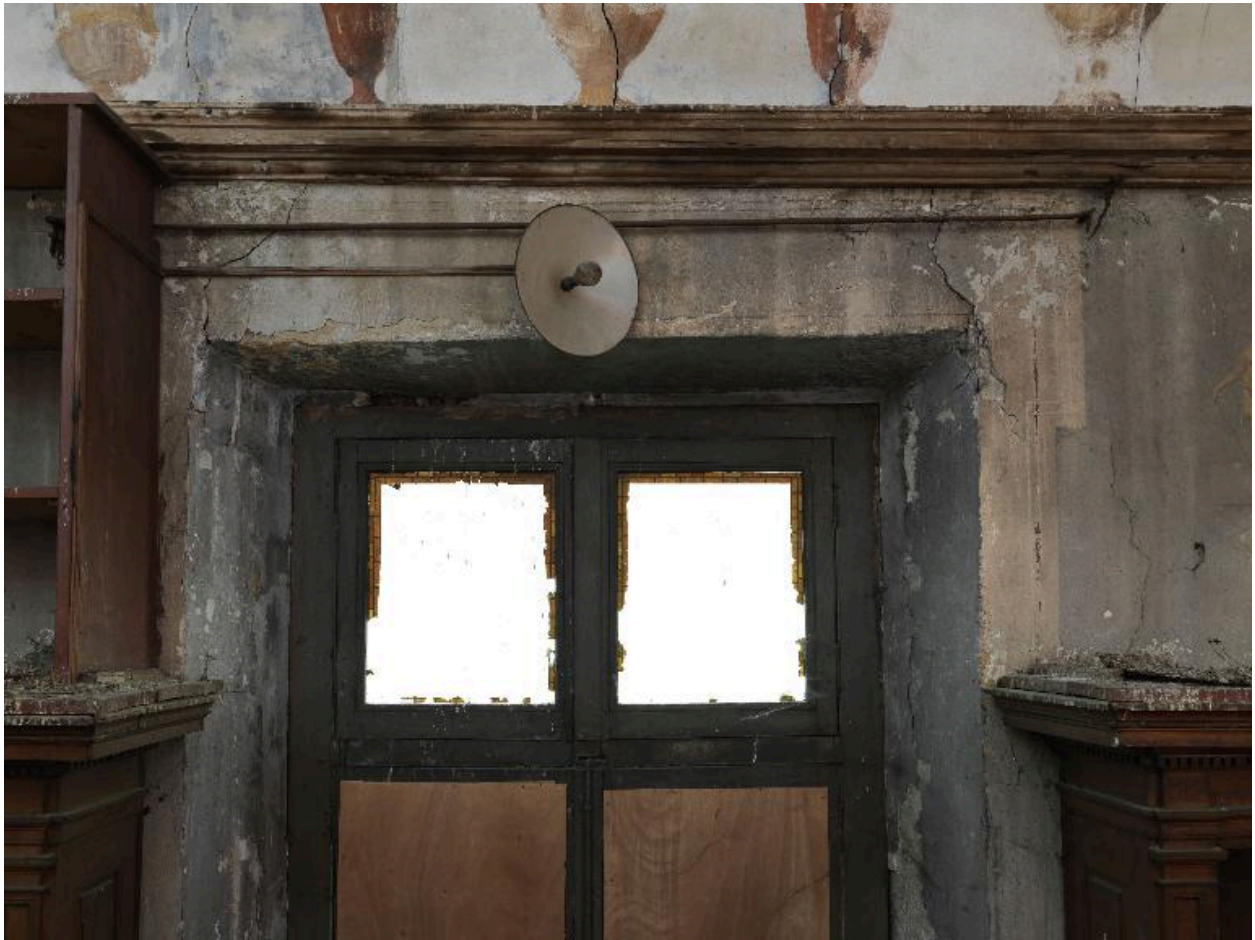
Mur sud, partie centrale
