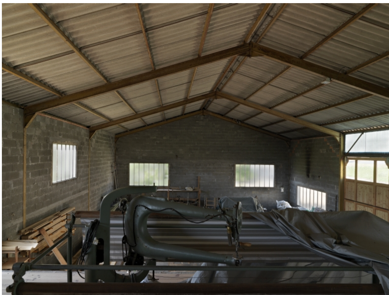
Vue de la charpente du nouvel atelier de 2011
