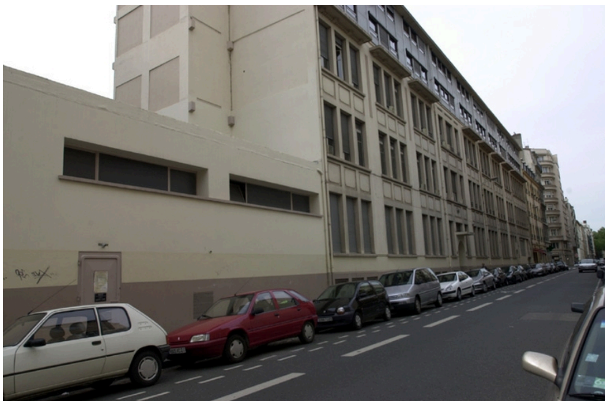
Vue générale nord
