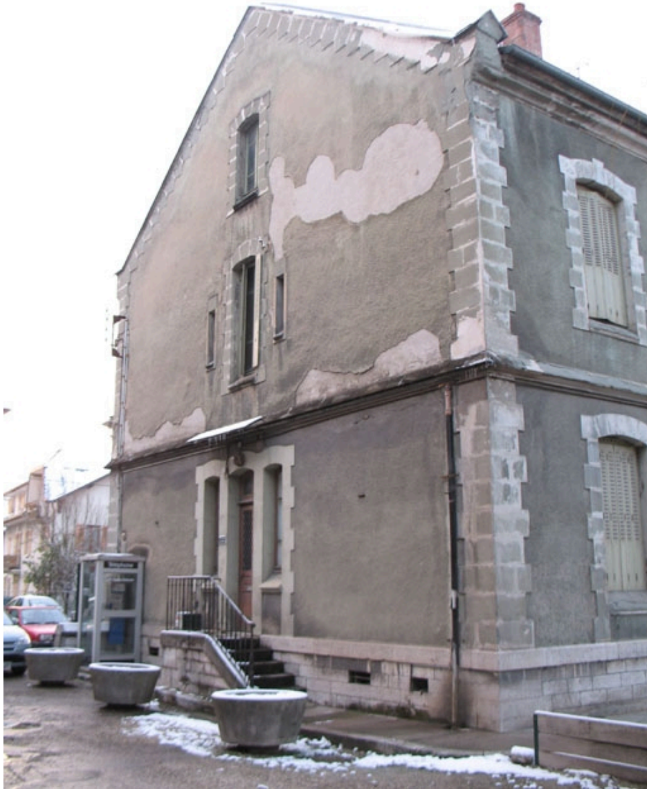
Pignon nord bâtiment administratif
