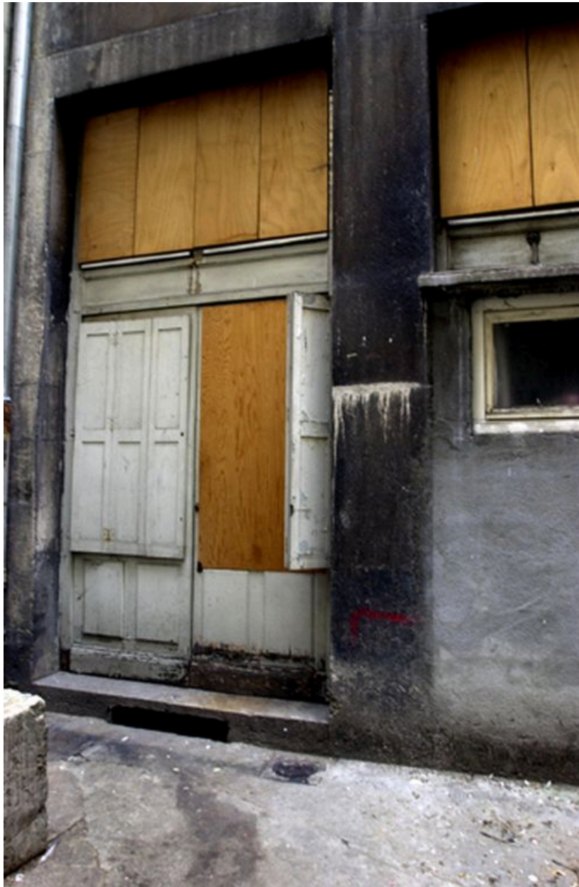
Elévation postérieure, l'appartement de gauche sur cour
