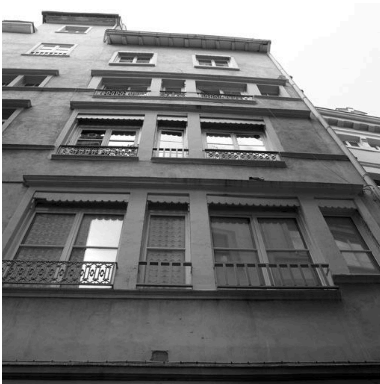
Façade, vue générale par-dessous
