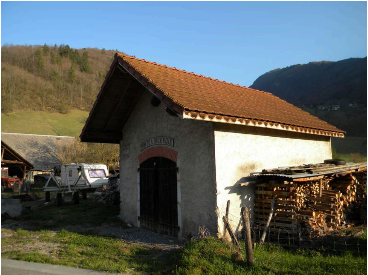
Vue de trois-quarts depuis la façade est.
