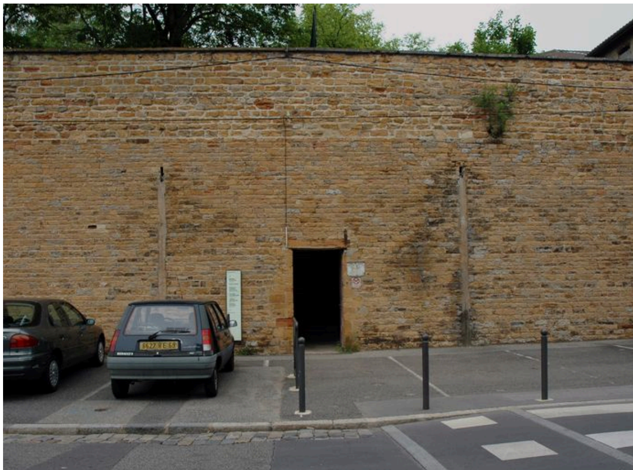
Mur de clôture sud-ouest et porte donnant accès au jardin public (ancienne porte d'entrée du couvent)
