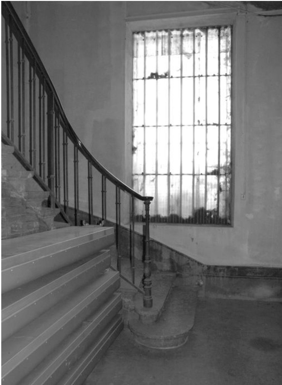
Bâtiment de la galerie, première volée de l'escalier
