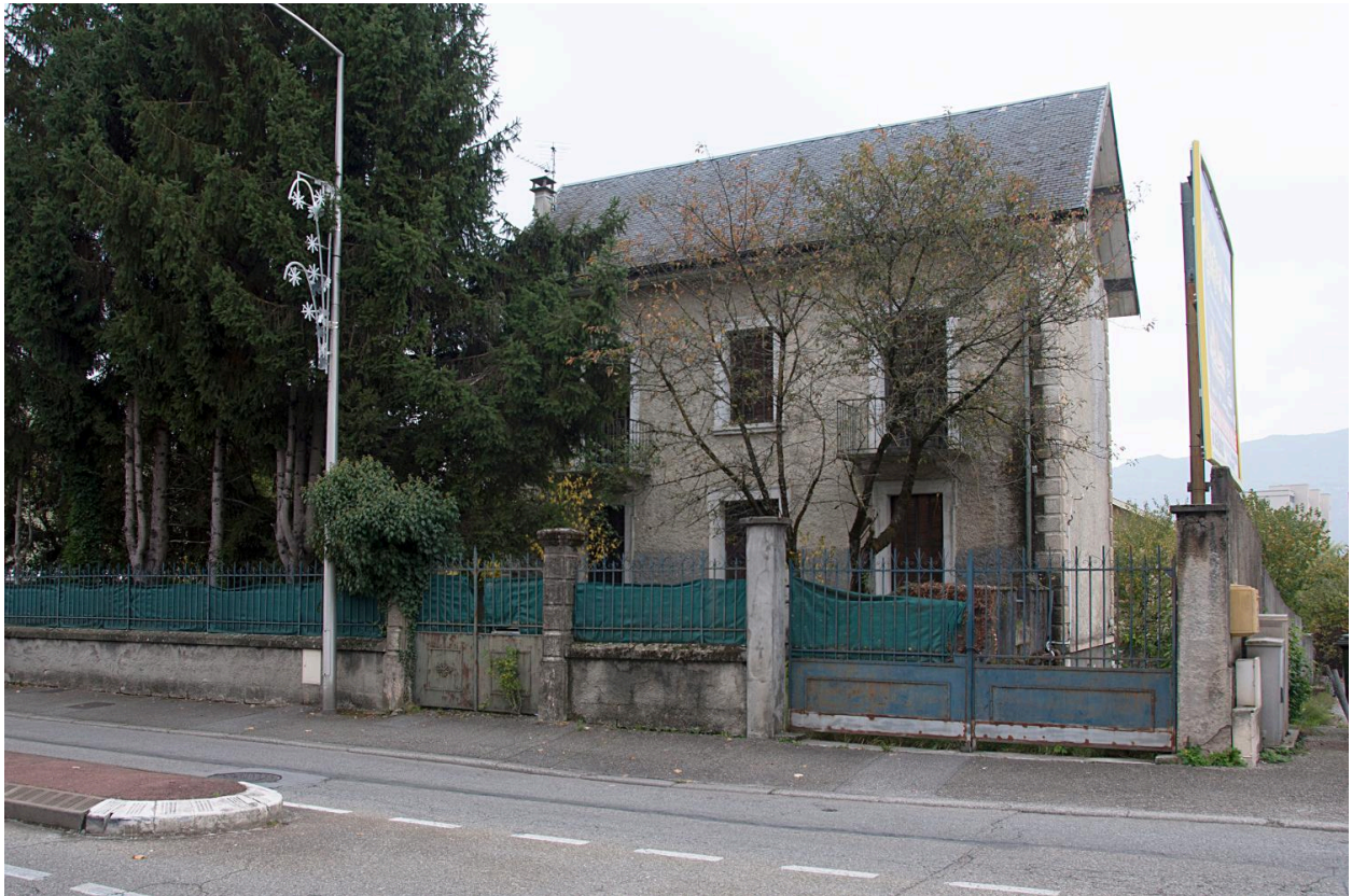
Vue générale (vue prise depuis le nord-est)
