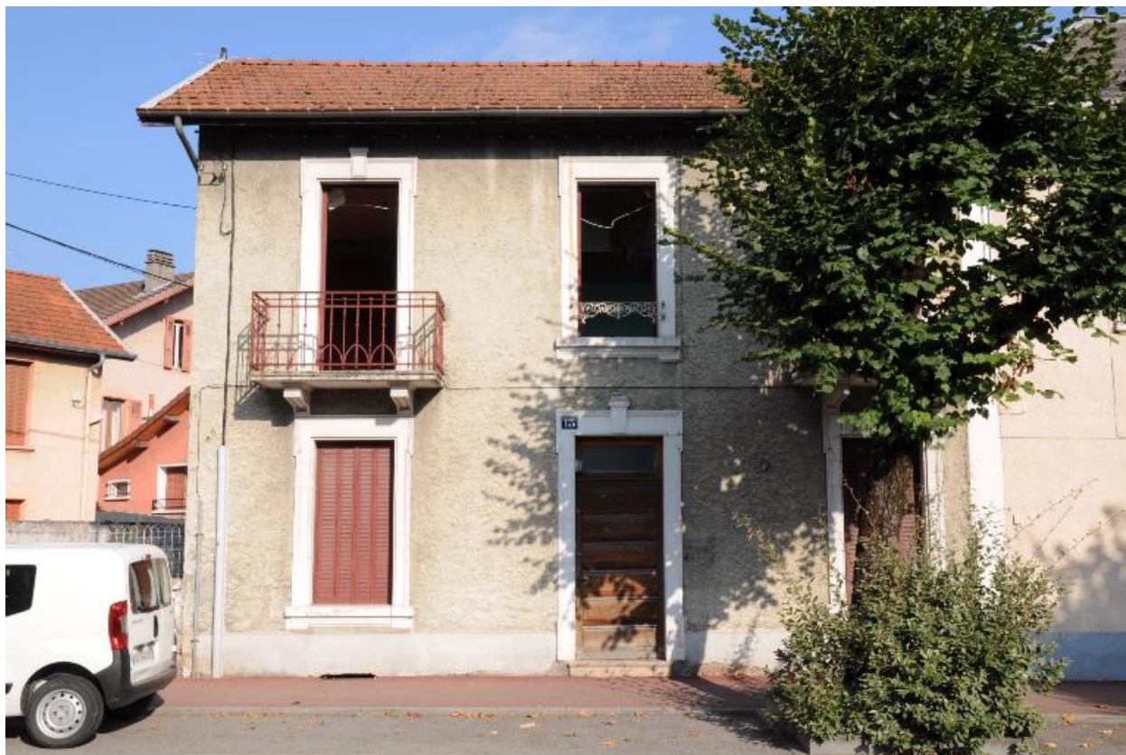
Maison, élévation sur l'avenue Saint-Simond
