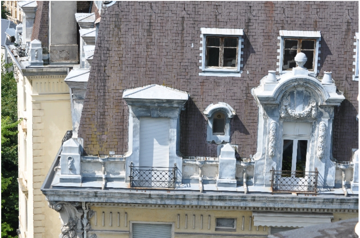
Détail des lucarnes
