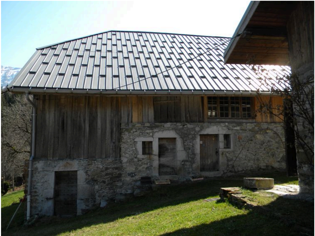
Vue du mur gouttereau nord-ouest.
