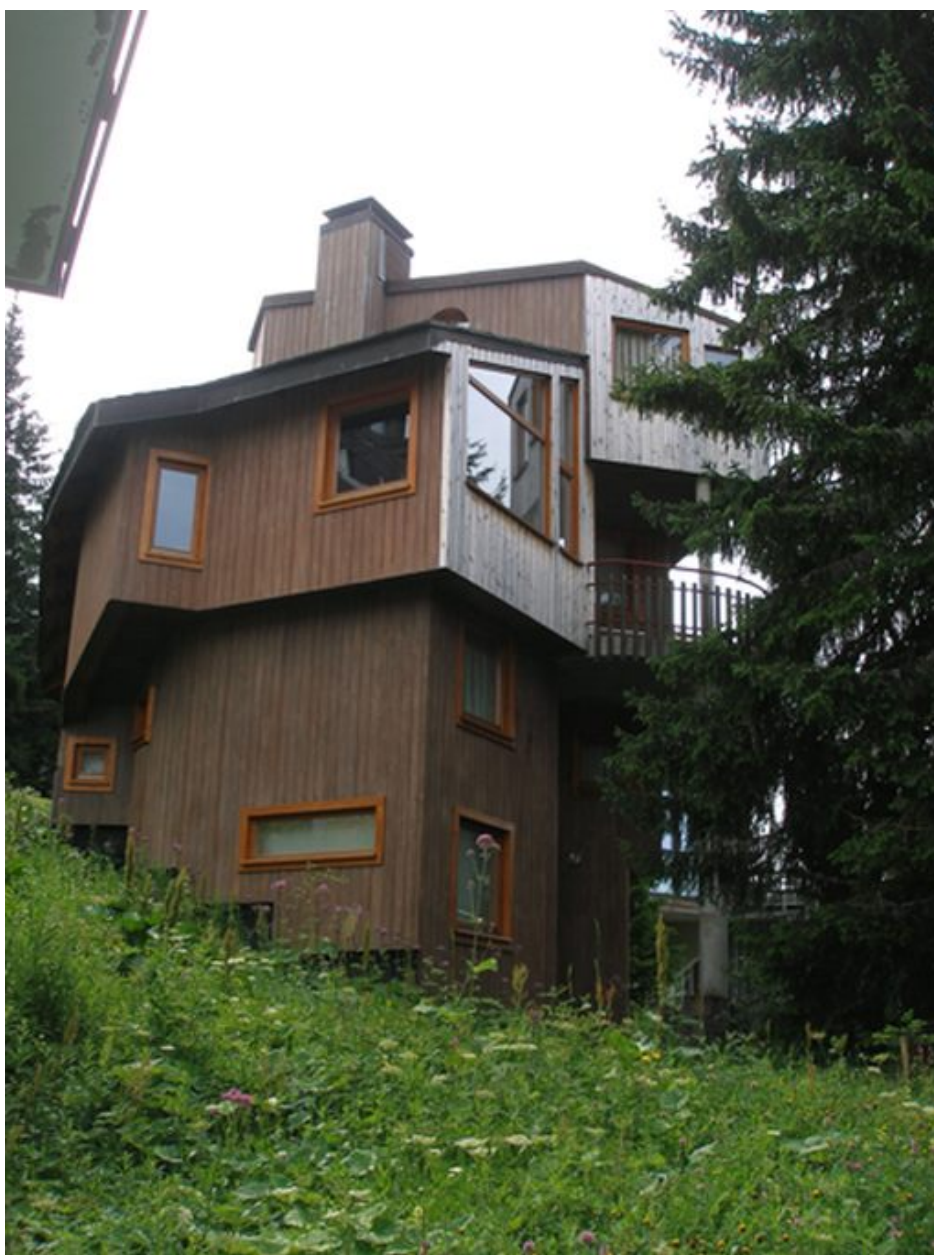
Elévation postérieure, côté aval
