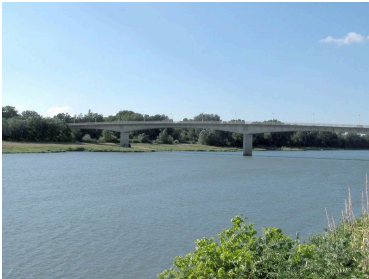
Vue partielle, face amont (depuis la rive droite)
