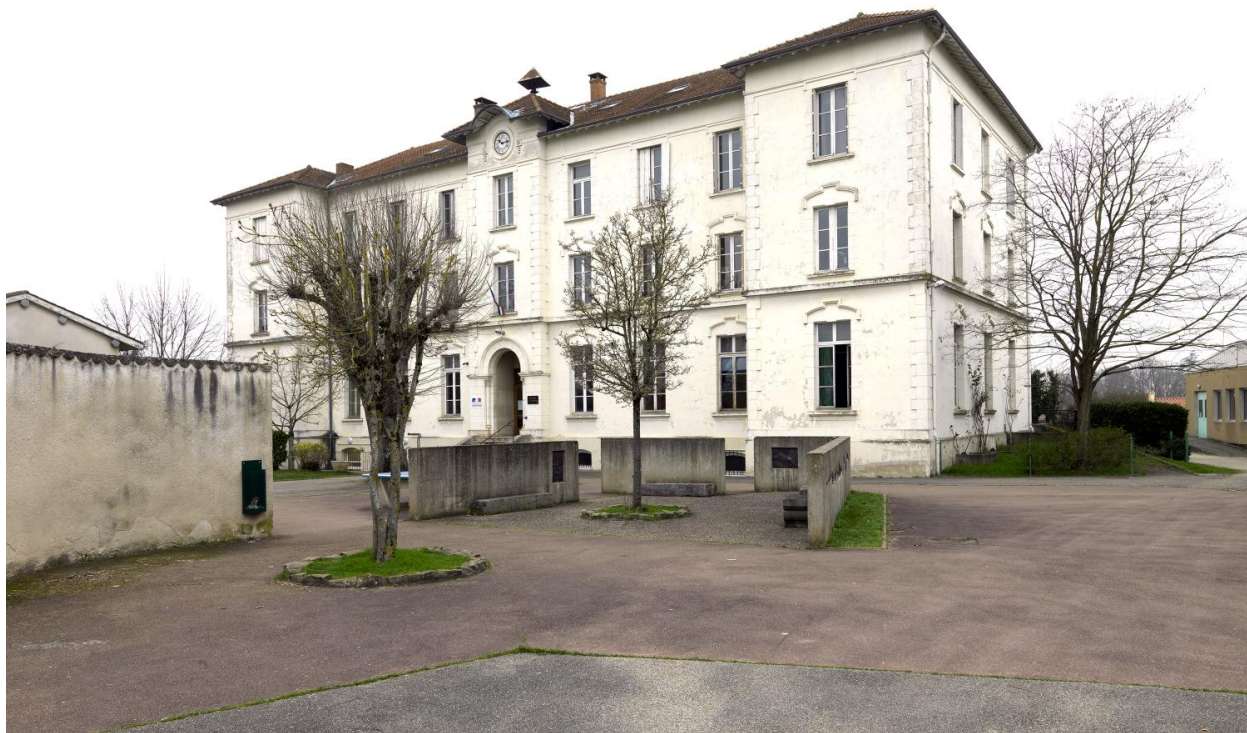
Vue de l'installation devant le lycée.
