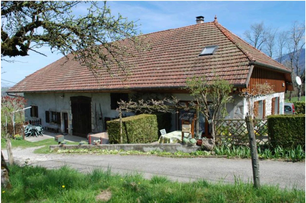
B5 339, Massettes (les), ferme, vue d'ensemble.
