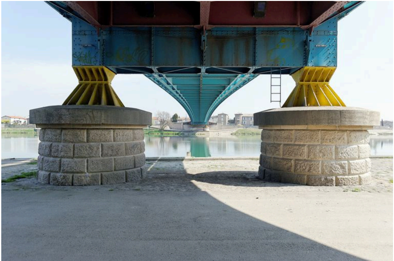
Vue du dessous du tablier, depuis la travée de rive droite
