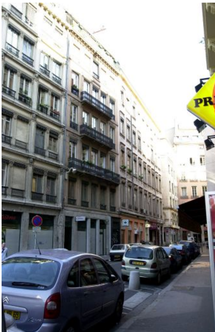
Façade sur rue, vue générale
